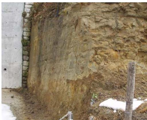
図一参 2.10 掘削対象地盤(風化砂岩)
