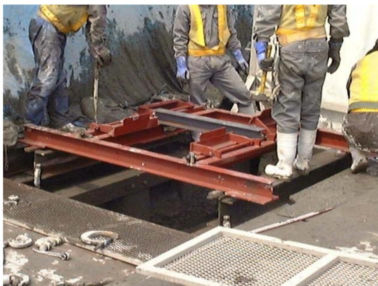
図一解 3.4.5 建込み定規設置状況
