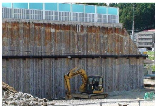
図一参 2.13 掘削後の鋼製連壁
