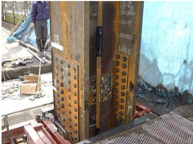
図一解 3.4.20 現場継手完了状況
