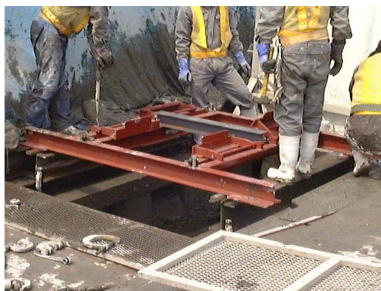
図一解 3.4.5 建込み定規設置状況
