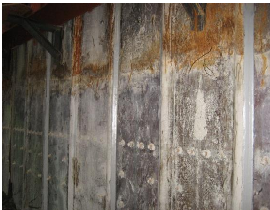
止水処置後の壁面（全体）
