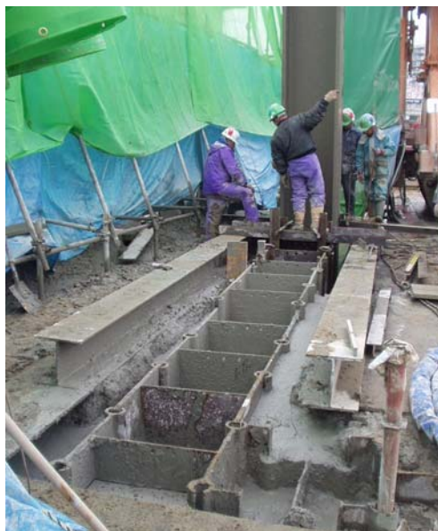
図一参 2.12 NS-BOX 建込み状況
