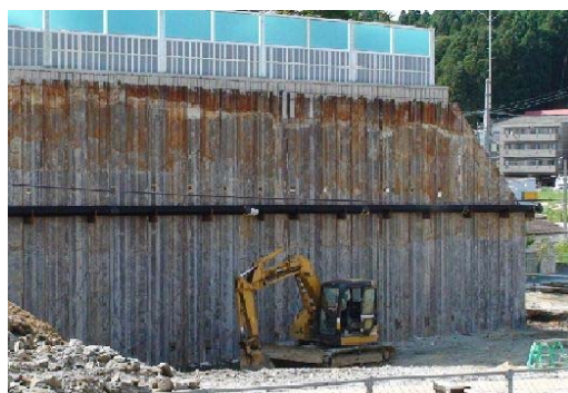
図一参 2.13 掘削後の鋼製連壁
