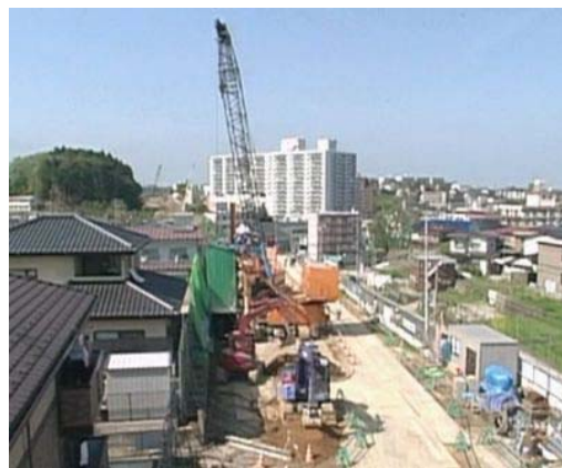
図一参 2.11 近接施工状況
