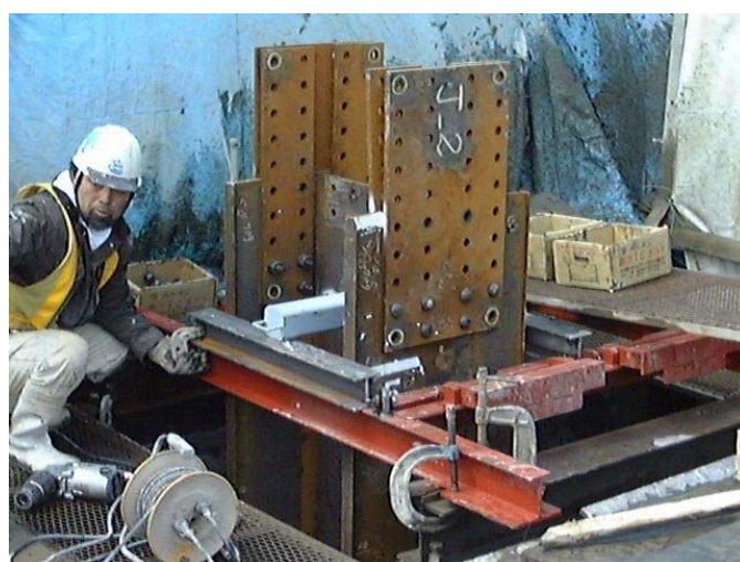
図一解 3.4.16 下部 NS-BOX の仮受け状況
