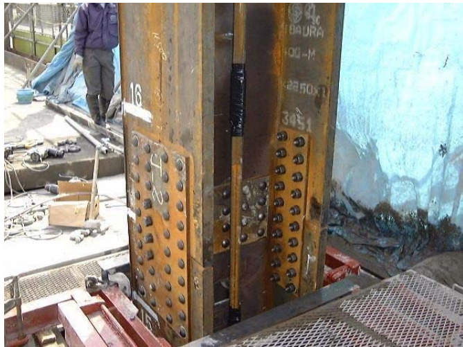
図一解 3.4.20 現場継手完了状況
