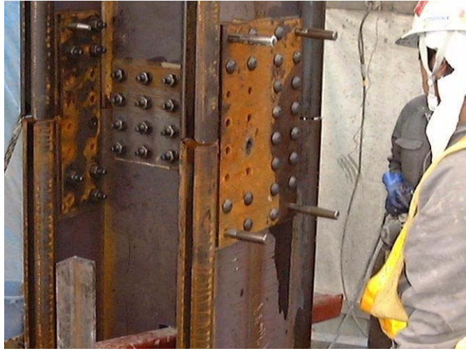
図一解 3.4.19 ドリフトピン打込み状況
