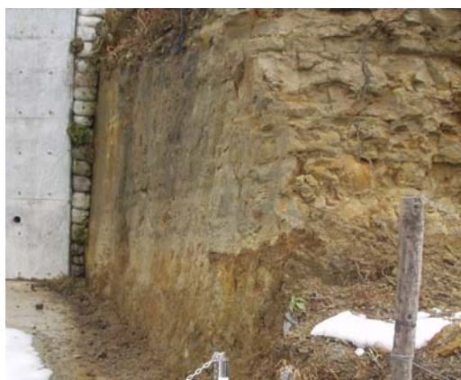
図一参 2.10 掘削対象地盤(風化砂岩)
