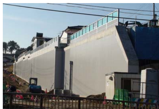
図一参 2.14 完成壁面(化粧パネル)
