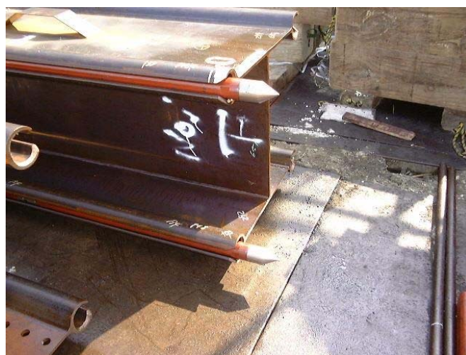
図一解 3. 4. 24 防護パイプ事前挿入状況
