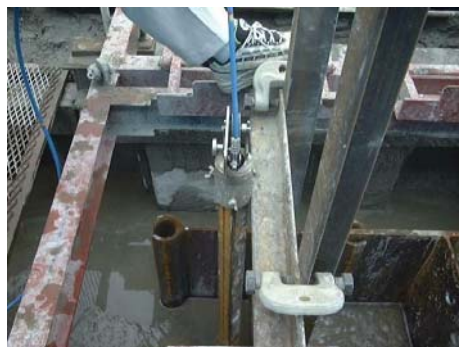
図一解 3. 4. 10 傾斜測定状況
