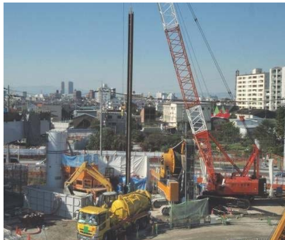
図一参 3.10 NS-BOX 建込み状況
